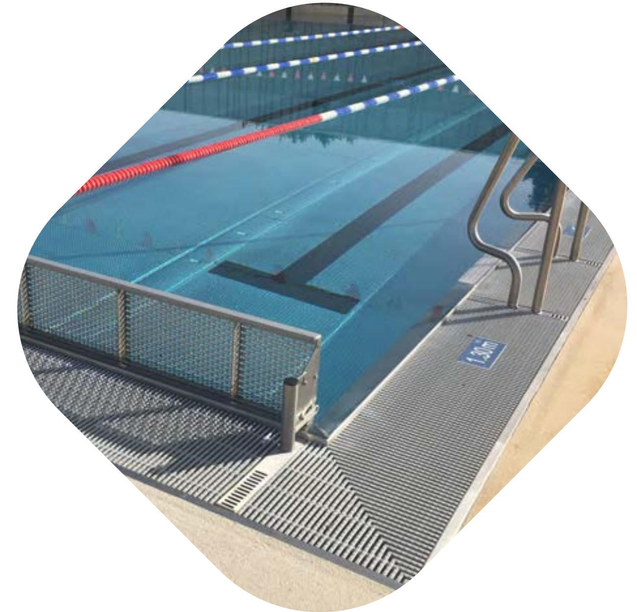
Accès facilité au bassin
